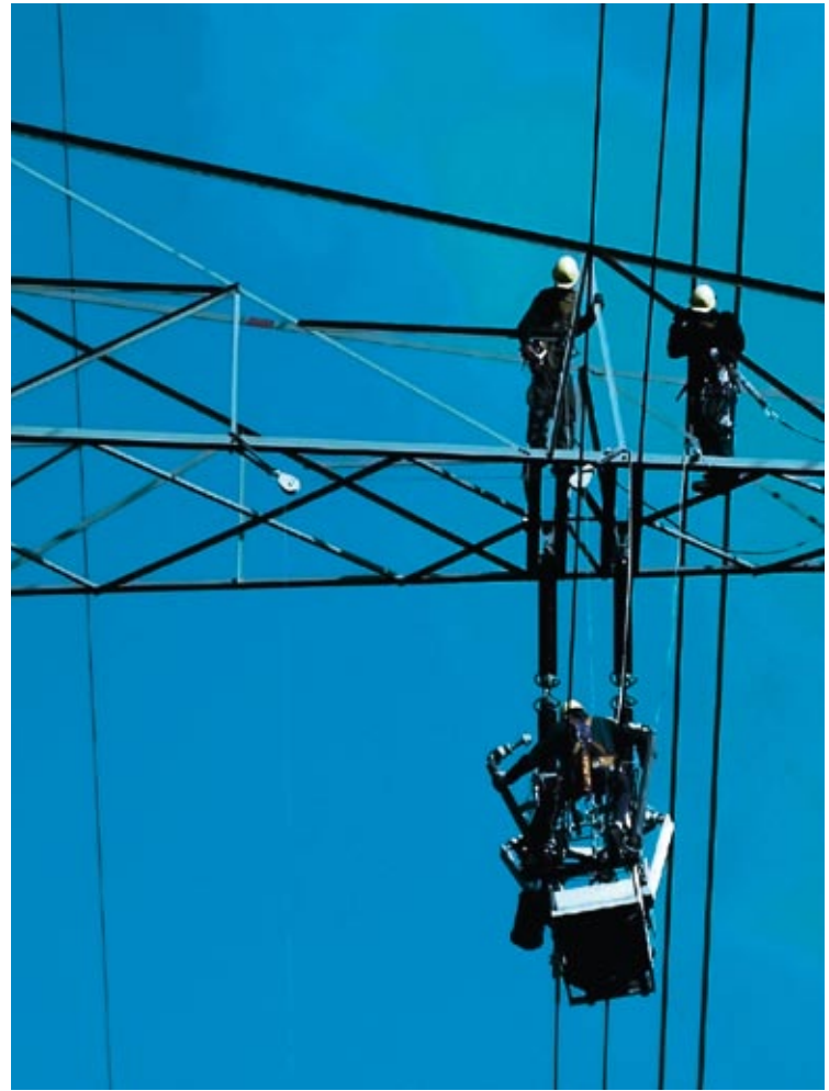
„Hoch hinaus“ – Montage- und Instandsetzungsarbeiten an einer Hochspannungsleitung
