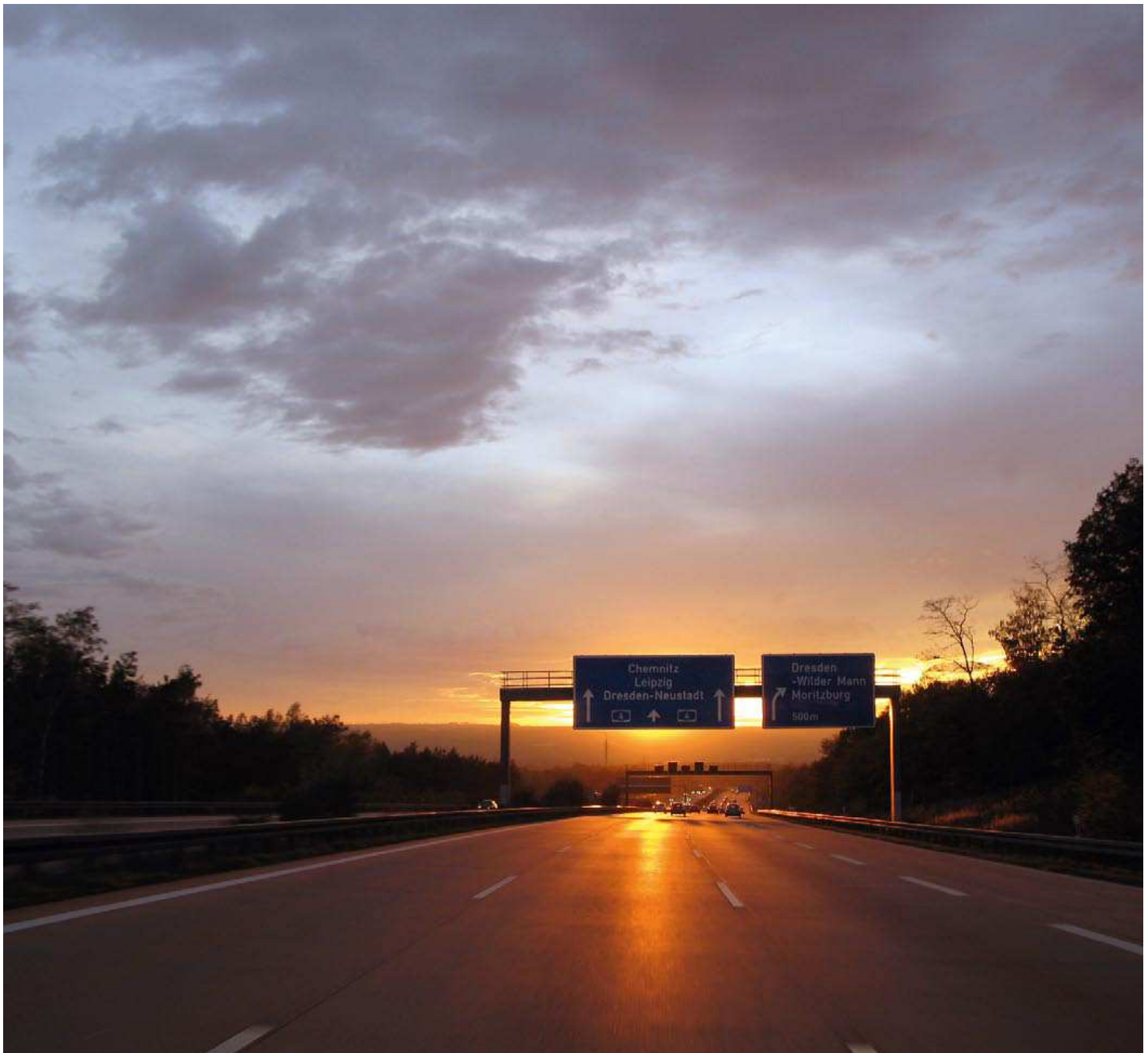
Glatteisfrühwarnanlagen an Autobahnen: hier ist eine präzise Überwachung der Stromversorgung notwendig.
