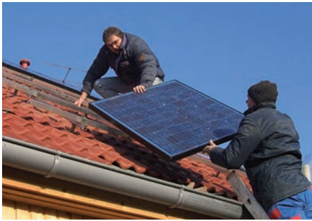
Anbringung von Solarpaneelen
